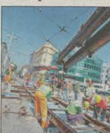
Arbeiter tauschen Gleise.
